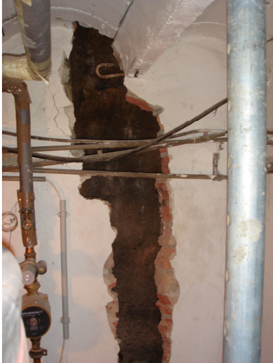
Abbildung 4: Rauchzug aufstemmen für das Einziehen eines flexiblen Edelstahlrohres und den Anschluss des Pelletskessels.
