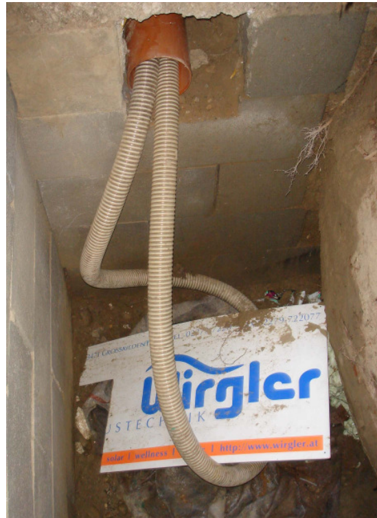
Abbildung 12: Motorenschacht mit Ansaugleitung (Der einfachste Regenschutz für den Motor war eine Bautafel)
