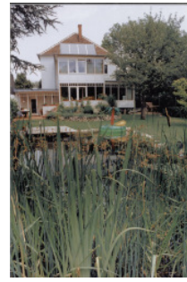
Abbildung 2: Haus Schuster mit dachintegrierten Solarkollektoren Jahr 2004
