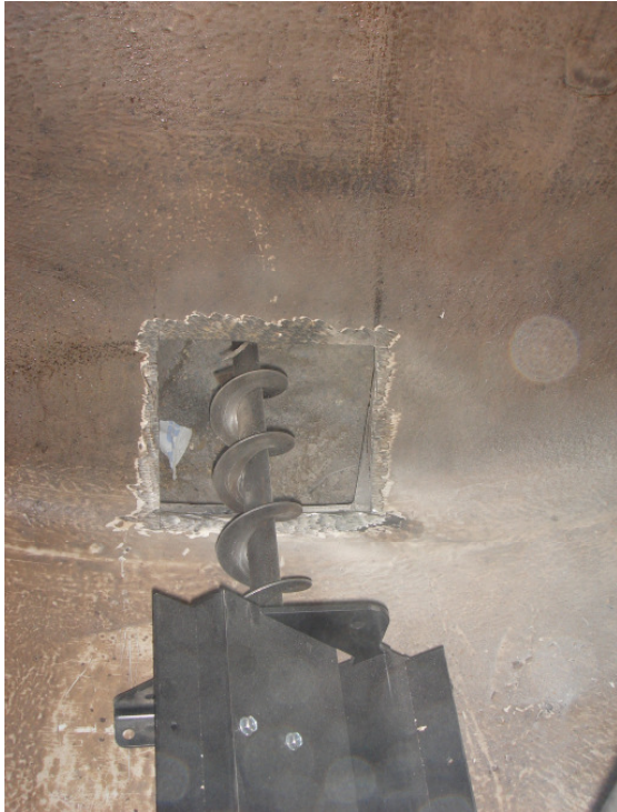
Abbildung 7: Stirnseitige Zylinderwand mit aufgeflexter Öffnung für die Durchführung der Förderschnecke im Bau
