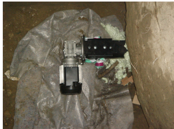
Abbildung 10: Blick in Motorenschacht mit Förderschneckenmotor
